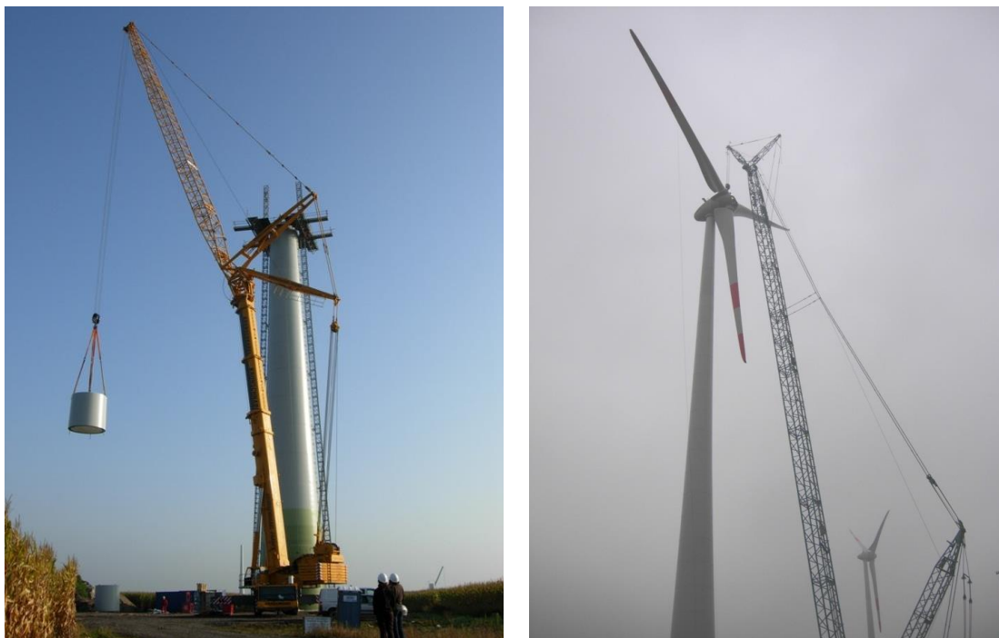
Montering av vindkraftverk. Foto: wpd
