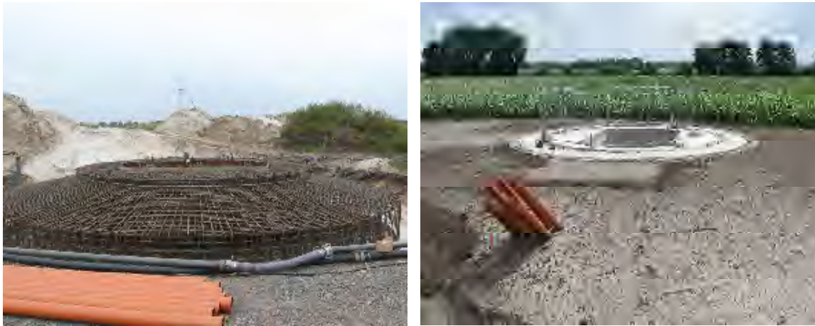
Exempel på konstruktion av gravitationsfundament. Foto: wpd.
