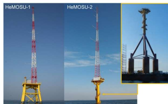
Figur 6. Alternativa fundamenttyper för mätmaster (K.-Y. Oh et al., 2018).
