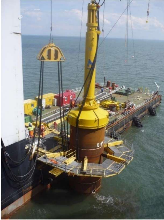
Figur 4. Installation av Monopile-fundament. Fotokälla: wpd (2013)
