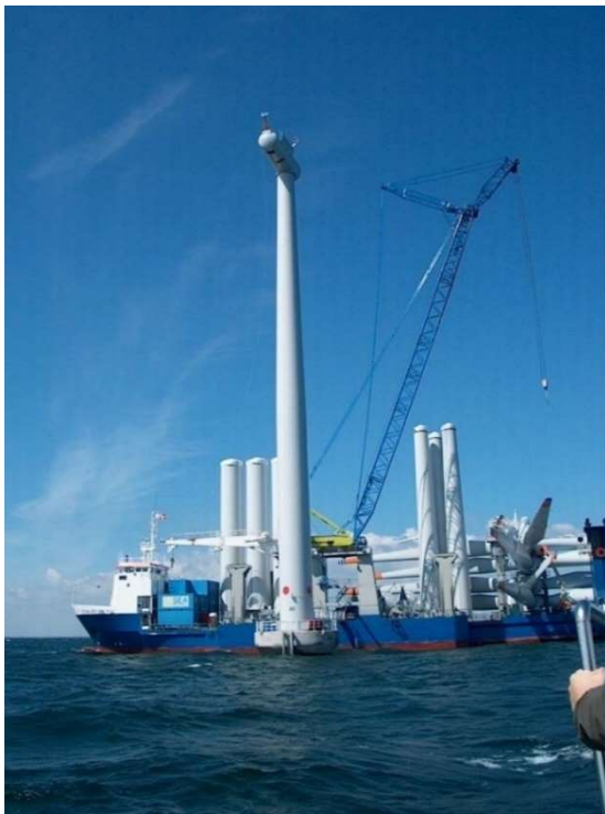
Figur 7. Installation av ett havsbaserat vindkraftverk (wpd, 2008).
