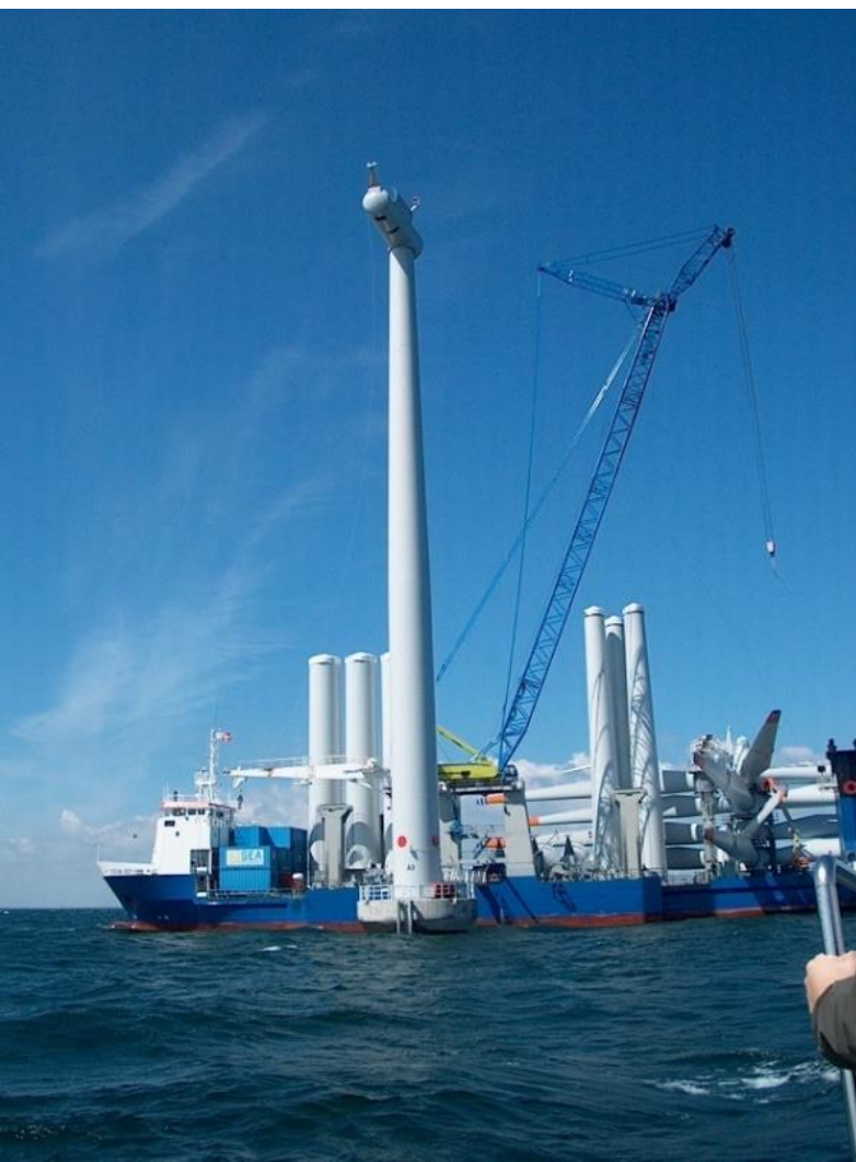
Figur 14 Installation av vindkraftverk (wpd 2008)
