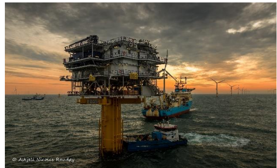
Figur 12 Havsbaserad transformatorstation. Fotokälla: CC Askjell (2016)
