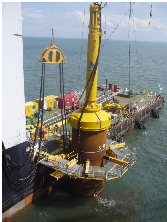
Figur 10 Installation av fundament Fotokälla: wpd (2013)
