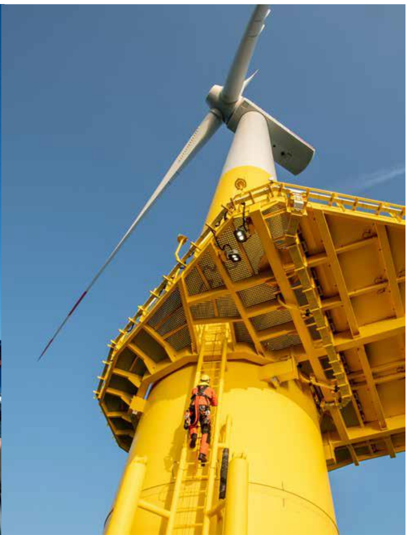
Figur 15 Installation av vindkraftverk Fotokälla: wpd (2008)
