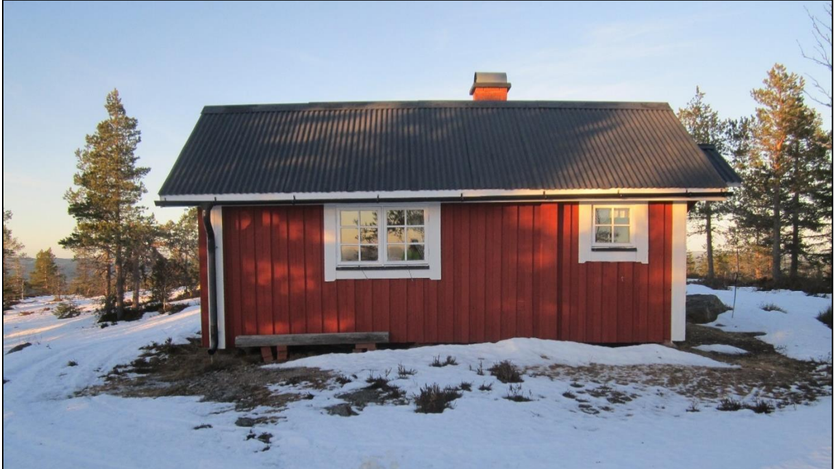
Figur 8. Den renoverade Brandvaktarkojan. Foto mot N: Ola Nilsson 2016.
