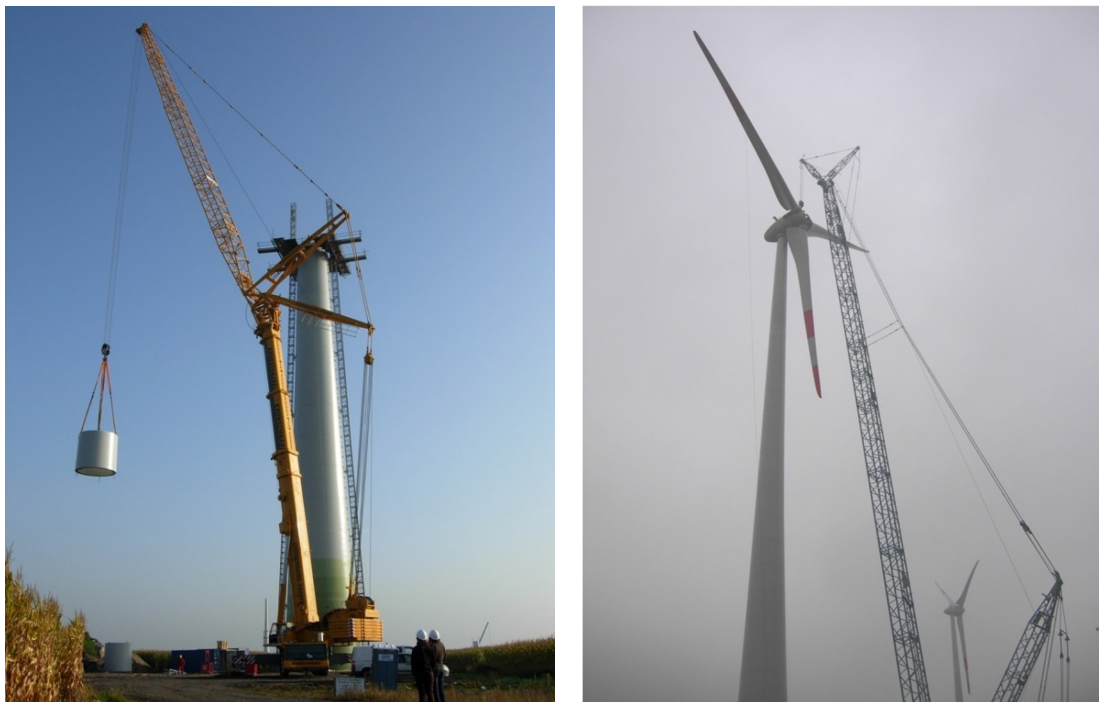
Montering av vindkraftverk. Foto: wpd
