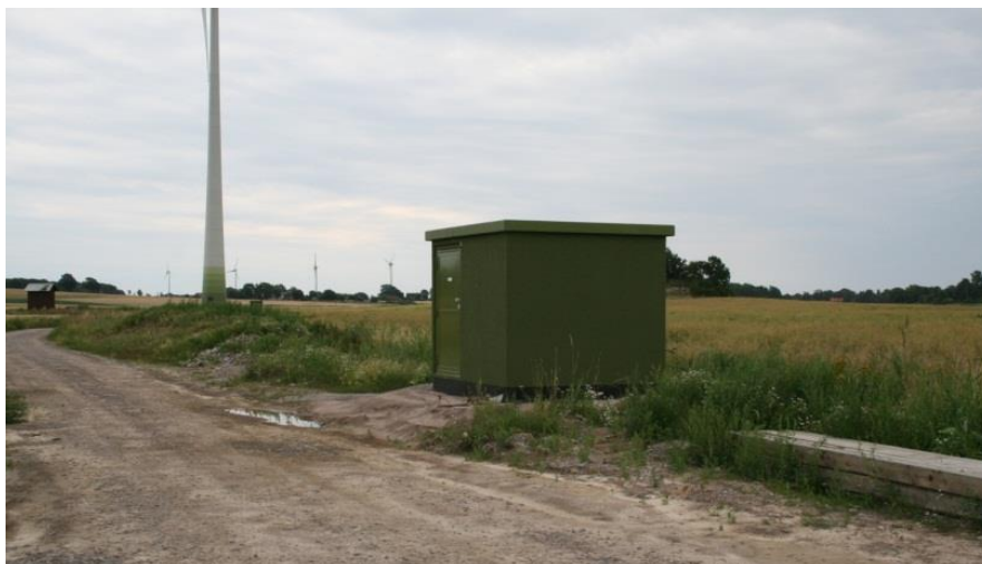
Transformatorbiosk vid vindkraftverk
