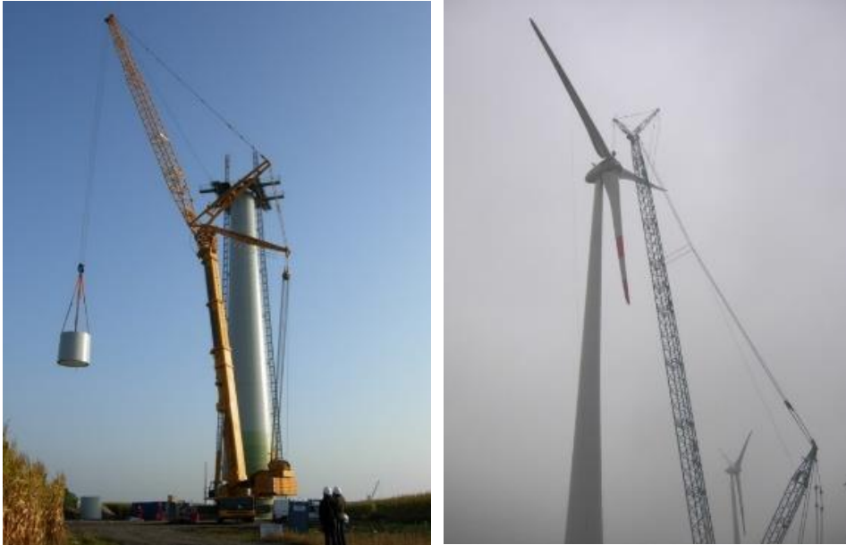
Montering av vindkraftverk. Foto: wpd
