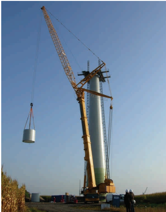
Montering av vindkraftverk. Foto: wpd
