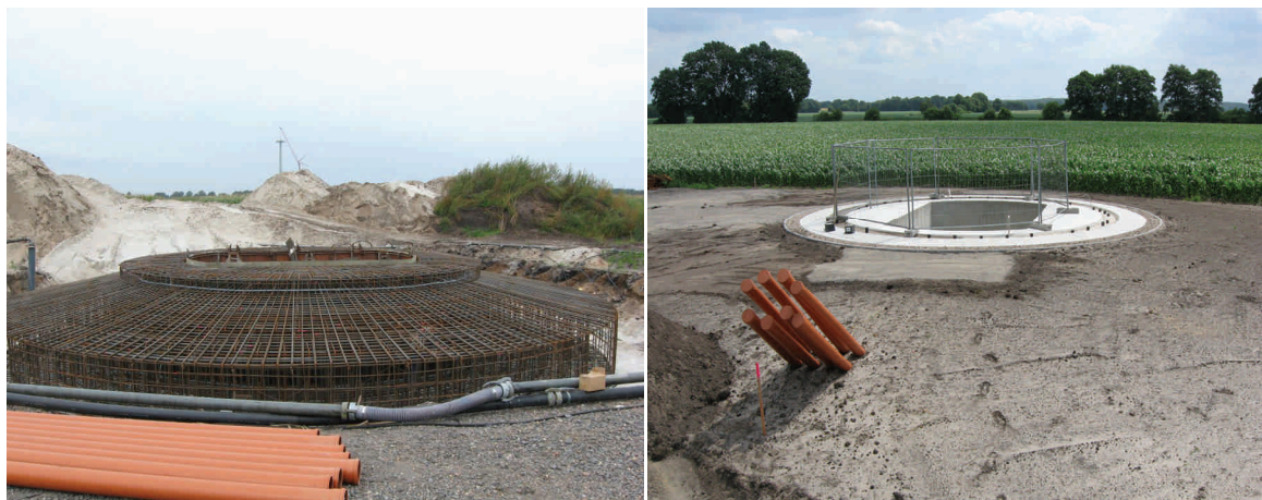
Exempel på konstruktion av gravitationsfundament. Foto: wpd.
