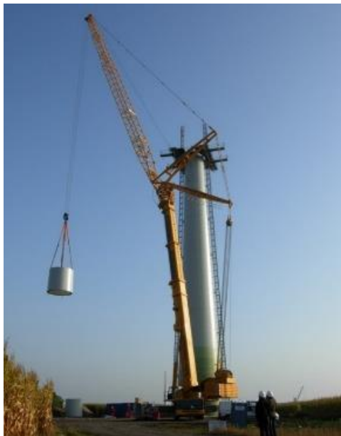
Montering av vindkraftverk. Foto: wpd
