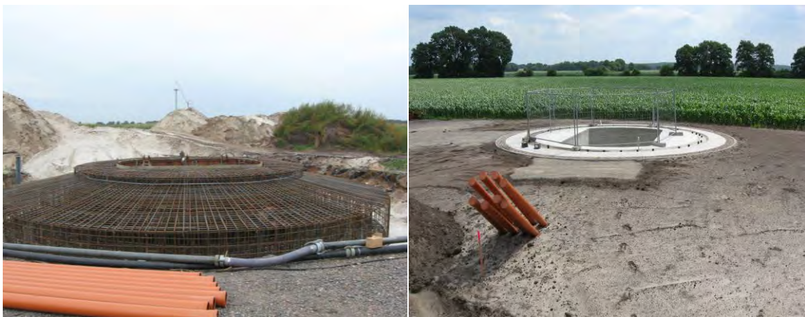
Exempel på konstruktion av gravitationsfundament. Foto: wpd.
