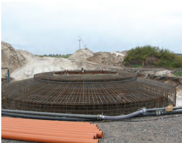
Exempel på konstruktion av gravitationsfundament. Foto: wpd.
