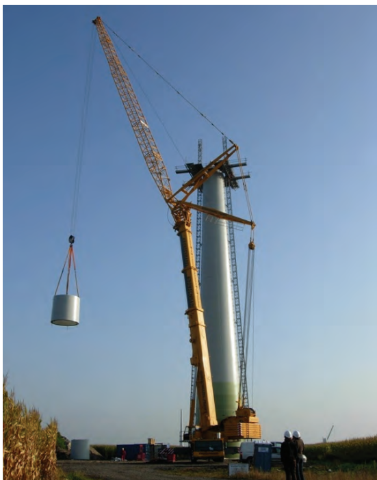
Montering av vindkraftverk. Foto: wpd
