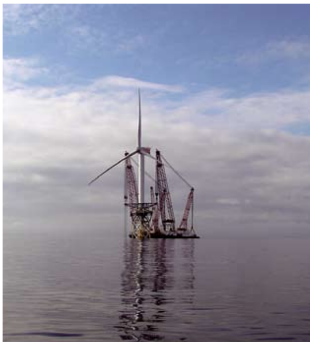
Figur 3.8. Anläggningskedan av havsbaserat vindkraftverk då Repower 5M installeras i en pilotanläggning utanför Skottland sommaren 2006. Foto: Copyright RePower.
