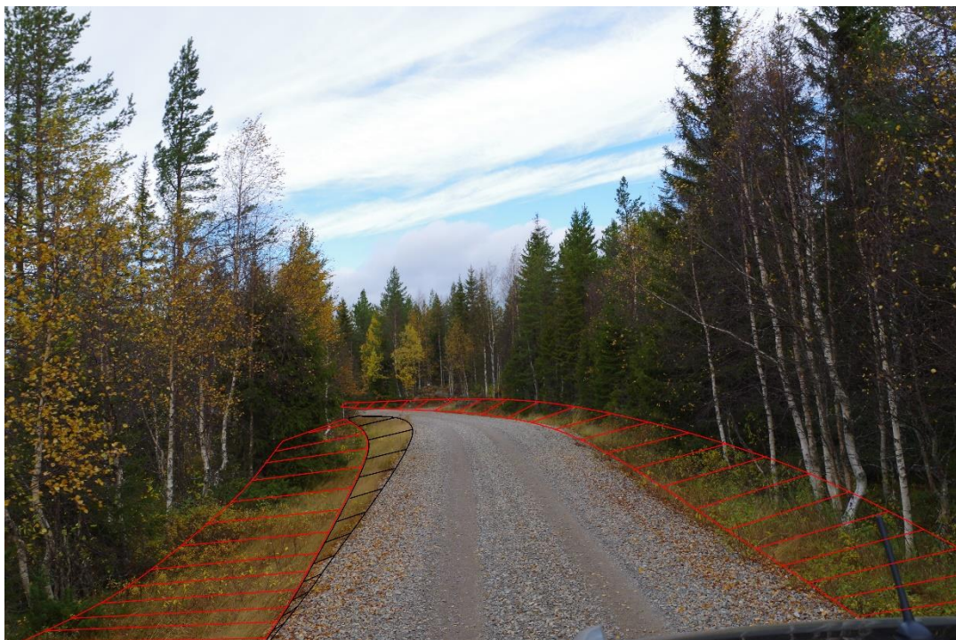
Figur 7-K. Fotomontageexempel över nödvändiga åtgärder för att utnyttja den befintliga skogsbilvägen för tunga transporter. Svart skraffering markerar breddning av väg, och röd skraffering behov av hindersfri yta.
