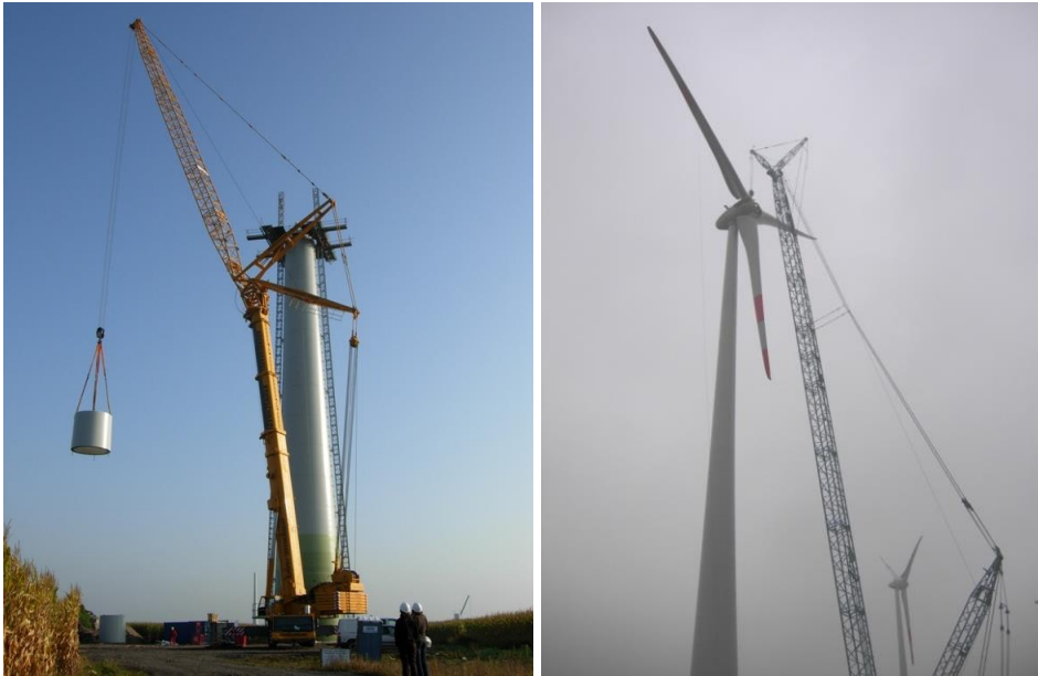
Montering av vindkraftverk. Foto: wpd
