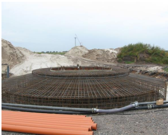
Exempel på konstruktion av gravitationsfundament. Foto: wpd.
