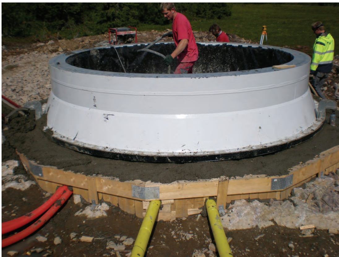
Figur 5-B. Grundläggning av bergfundament, foto wpd.
