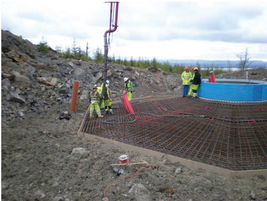
Figur 5-A. Grundläggning av gravitationsfundament, foto wpd.
