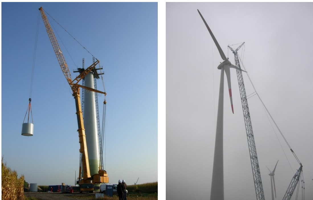
Montering av vindkraftverk. Foto: wpd
